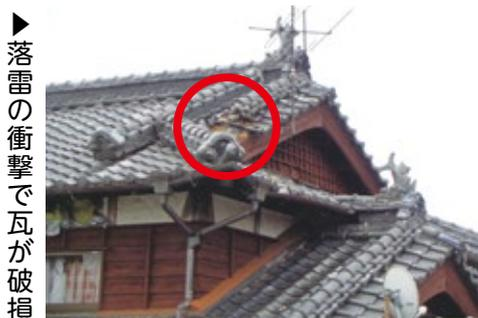
▶ 落雷の衝撃で瓦が破損
