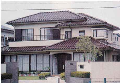
木造で、外壁のすべてがモルタル・サイディングなど不燃材料で被覆されたもの。
